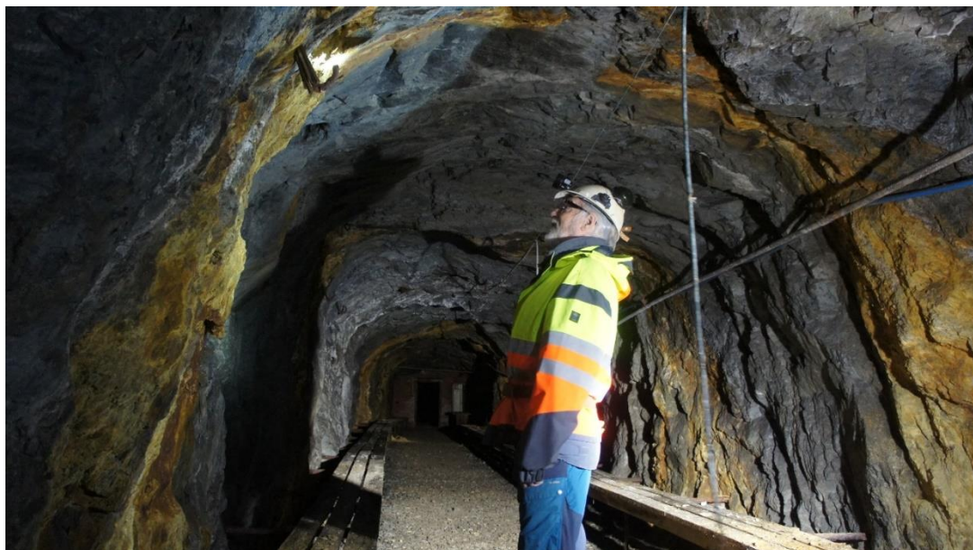
Figur 4. Utsyn over en del av tilfluktsrommet. I forgrunnen svovelkisholdig sleppe.
